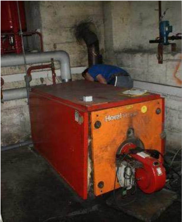
Quelle: Kurs der Kantone Luzern/Aargau „Heizungs-Check“
